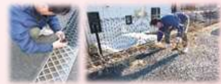
顧客サポ-ト課のスタッフで駐車場のメンテナンスをしました！草むしり・入口ステップの交換などを行い、快適な環境づくりを心掛けています！
