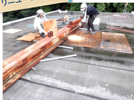
屋上での工事の様子
